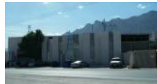
Master Classic Centro de Mantenimiento y reparación de Máquinas Electrónicas
