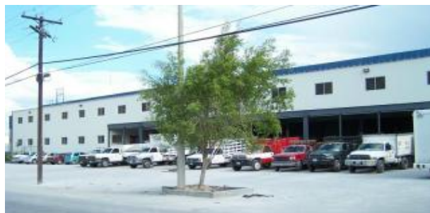
Ajegroup Cedis Santa Catarina. Proyecto Llave en Mano en Arrendamiento. El alcance incluyó: Nave Área de Almacenaje, Edificio de Oficinas y Área de Maniobras y Andenes.
