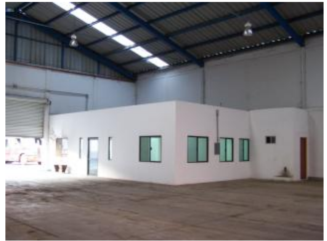
VISTA ORIGINAL DE OFICINAS
